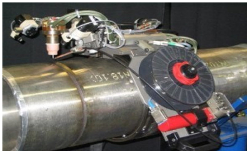
Рисунок 9 - Автоматическая и полуавтоматическая сварка трубы
