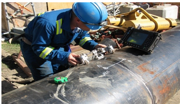
Рисунок 16 - Контроль качества сварных соединений
